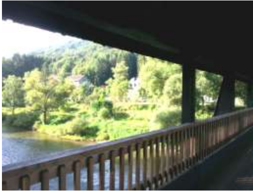
Holzbrücke über die Sauer
